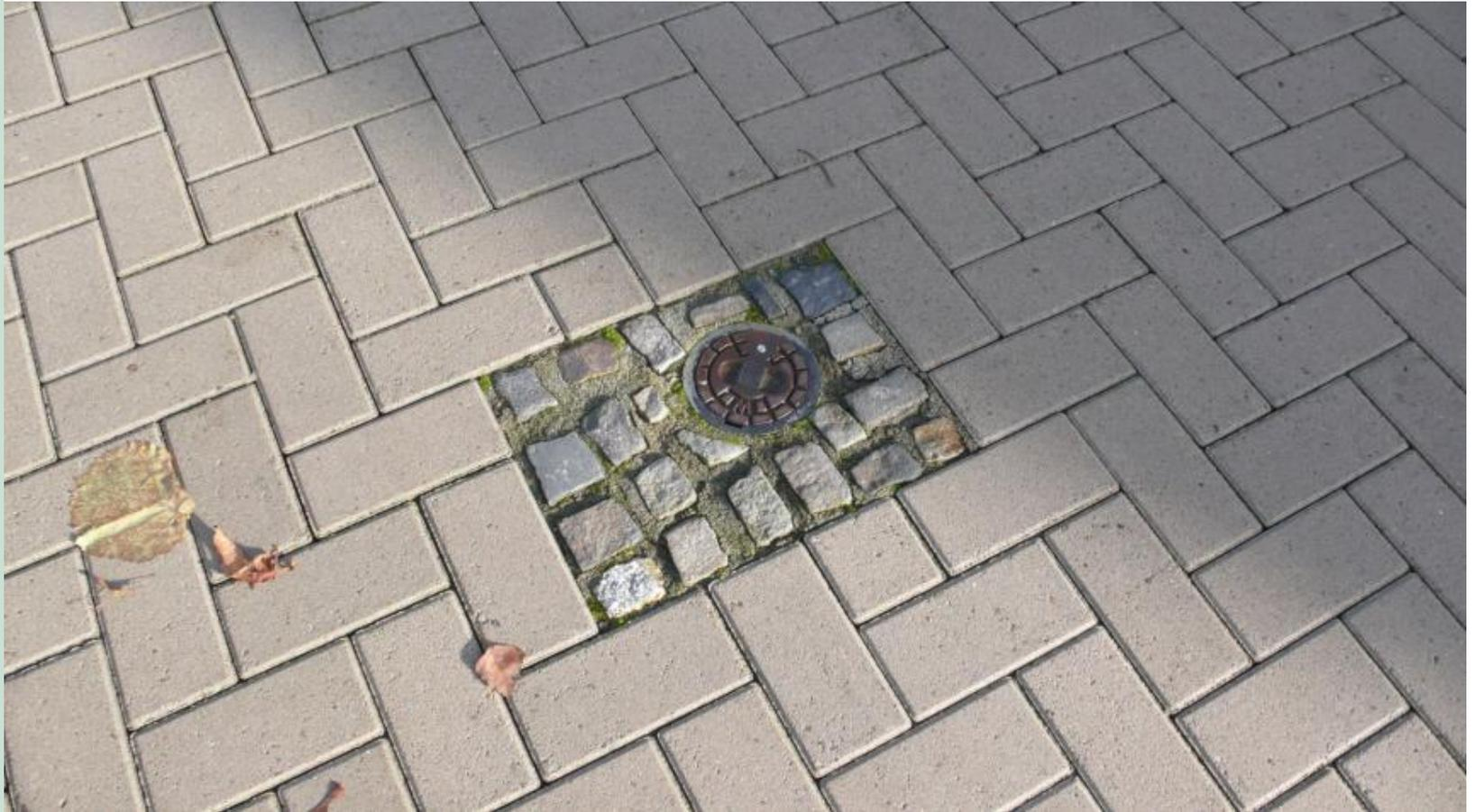
Rechteckpflaster Grau mit Einbau Wasserkappe
